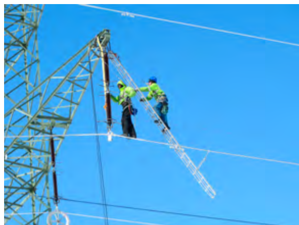
Prace naciągowe na linii WN
