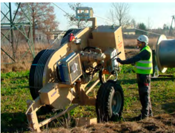
Stanowisko maszyn do wykonania prac naciągowych
